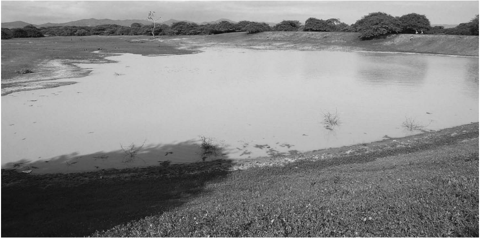
Fig. 13. El jagüey o albarrada de San Javier (provincia del Guayas, Ecuador) cuenta con un canal alimentador y un rebose o desfogue. La vegetación arbórea forma parte del conjunto y propicia la diversidad biótica local así como las visitas de bañistas de la comuna de Tugaduaja y alrededores
